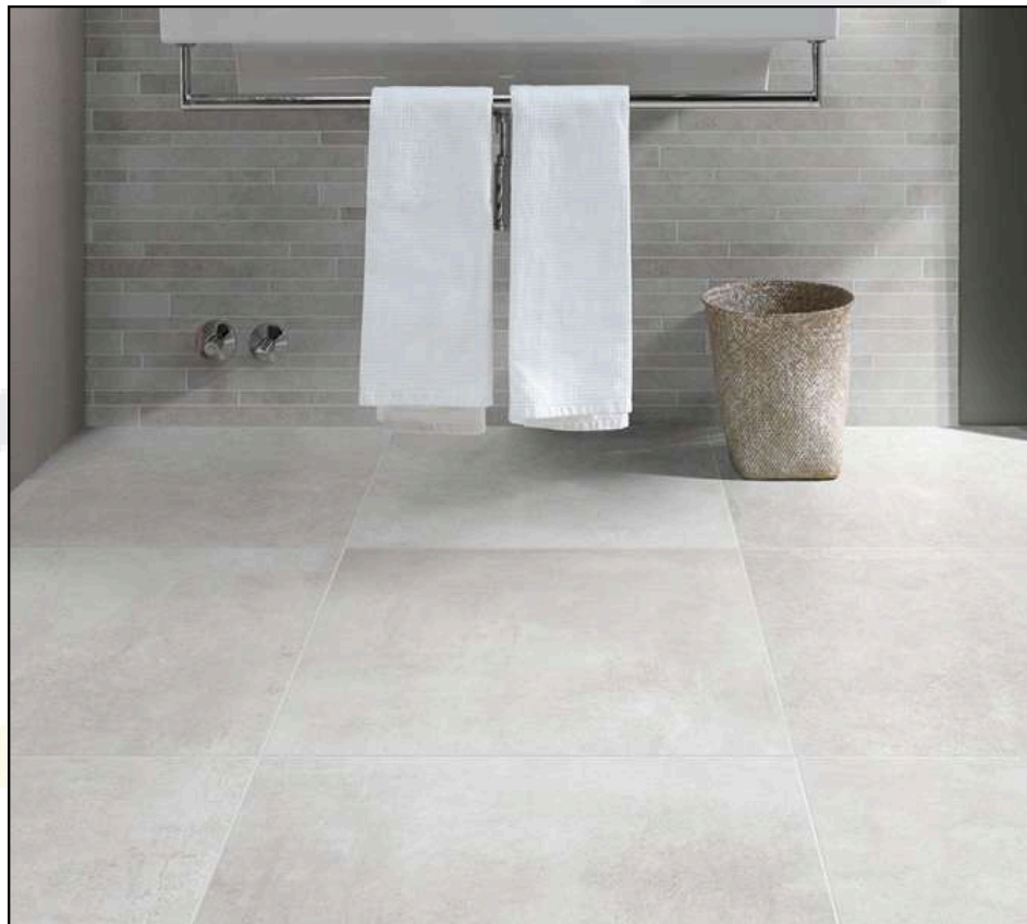
Dans les salles de bain et WC carrelage en 45x45 cm en pose droite collée ou scellée sur résilient phonique avec plinthes assorties
