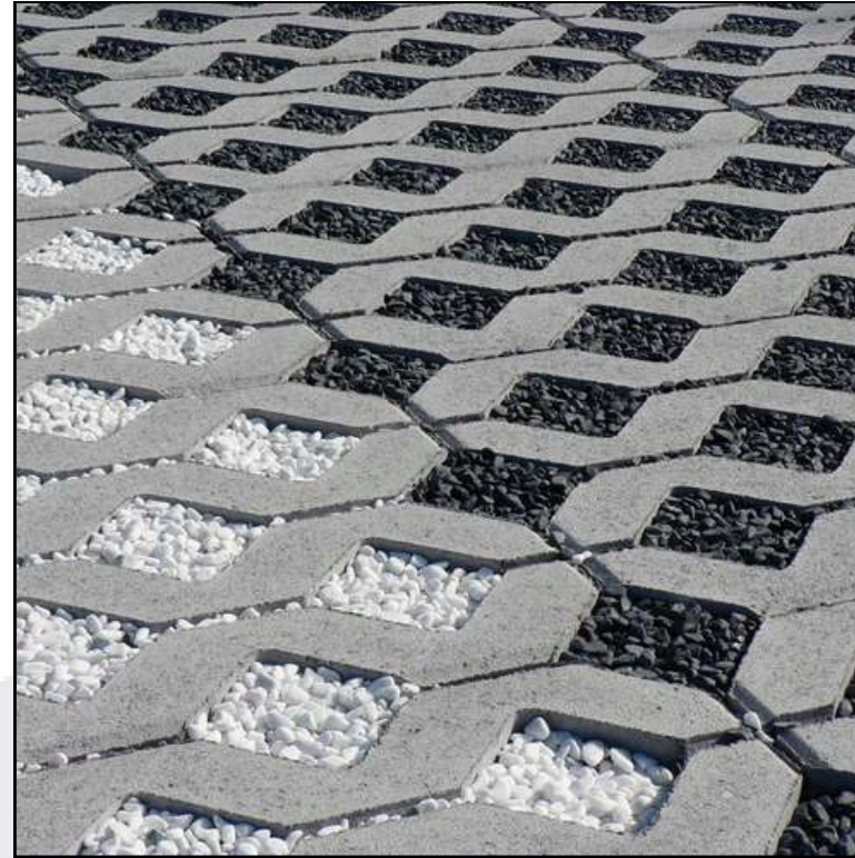
Stationnement sur dalles type pavés béton filtrant
