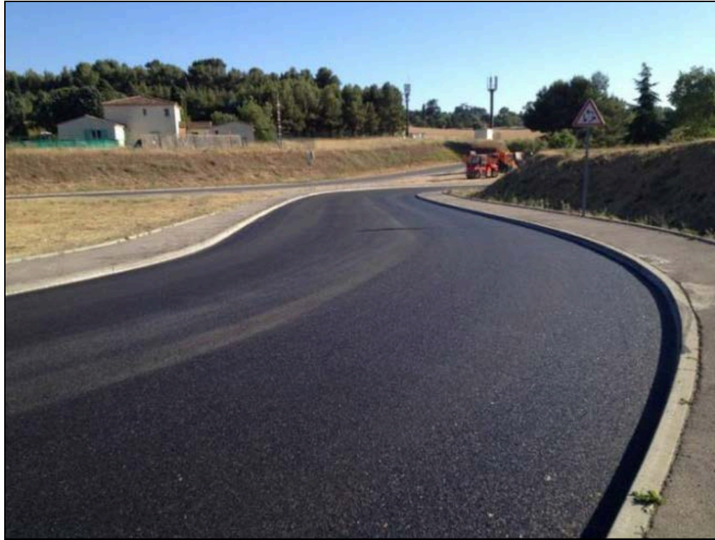
Voirie en enrobé
