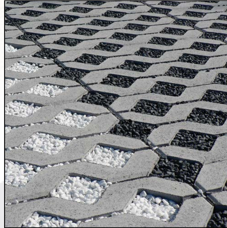
Stationnement* sur dalles type pavés béton filtrant
