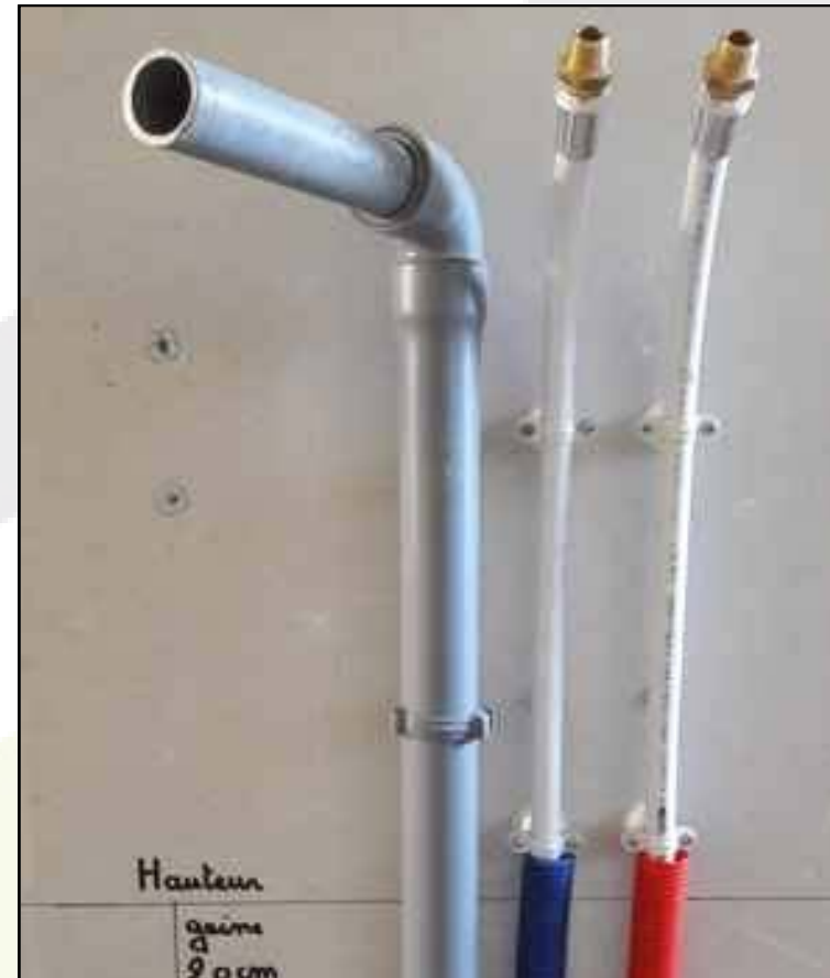
Attente d'eau chaude et froide avec évacuation
