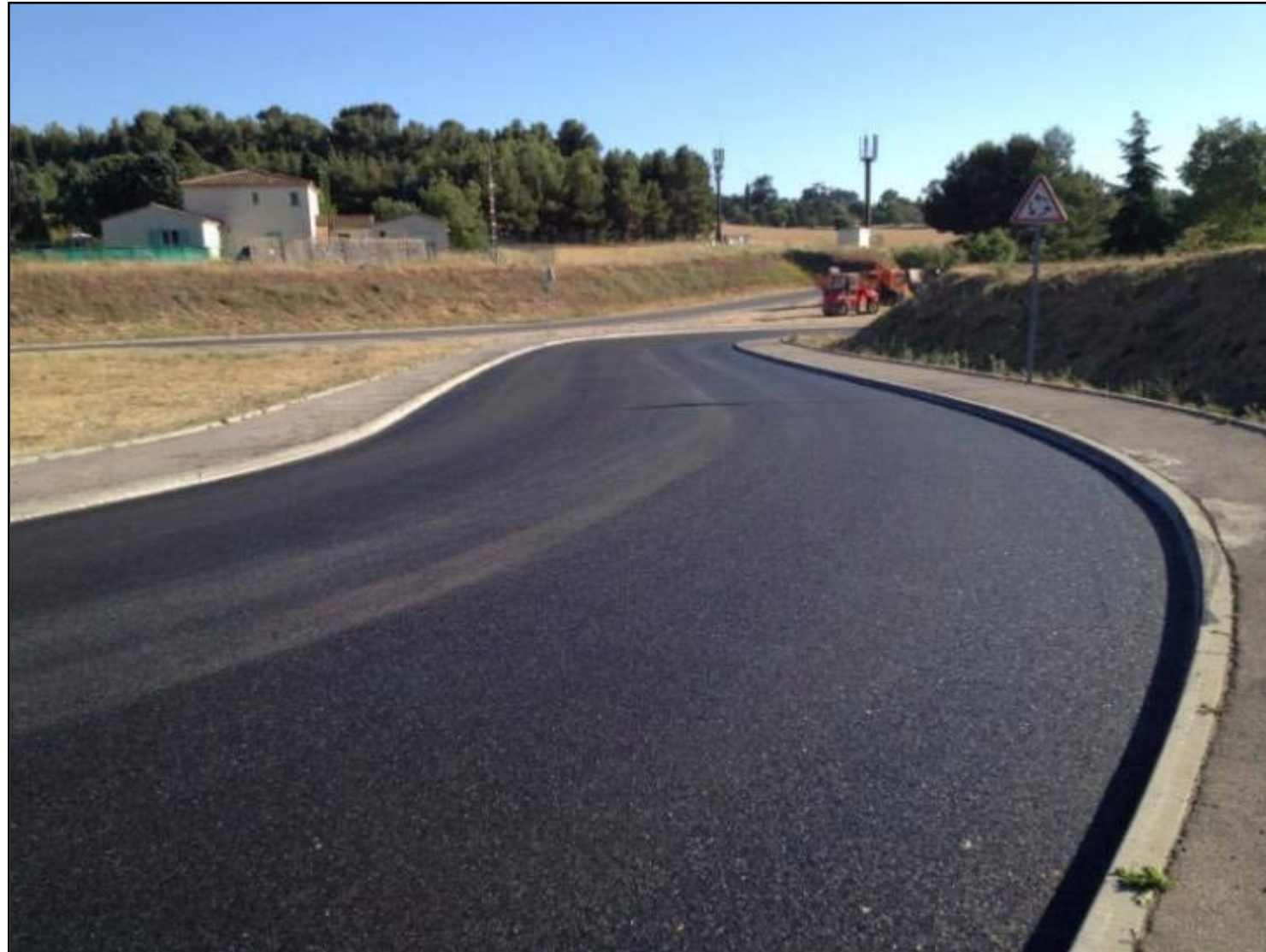
Voirie en enrobé
