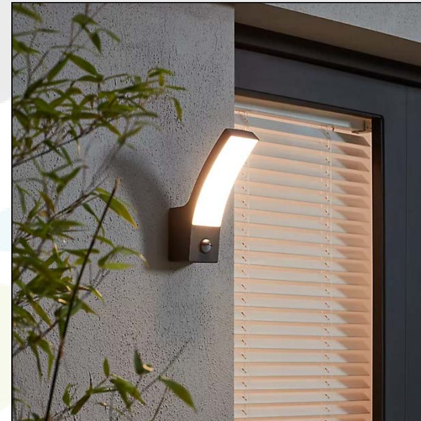
Un luminaire extérieur par point de sortie
