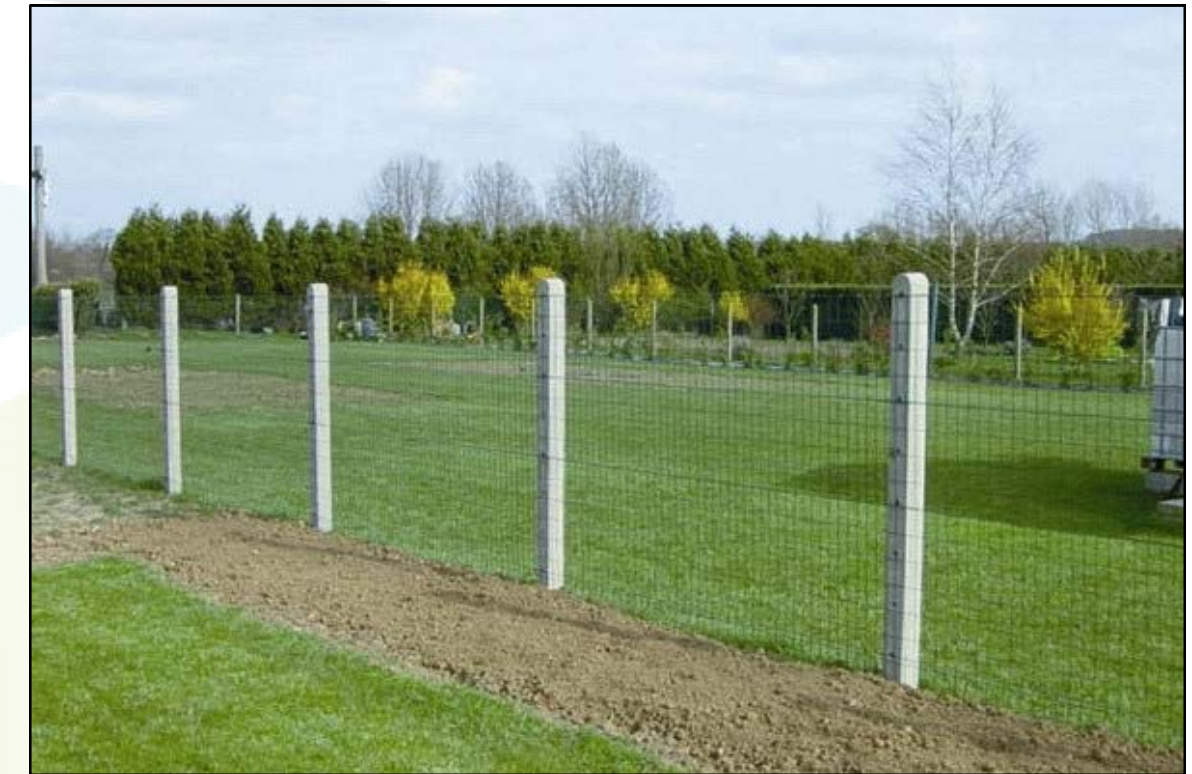
Clôtures souples (1.20m) séparatives entre parcelles et clôtures rigides (1.20m) en périphérie
