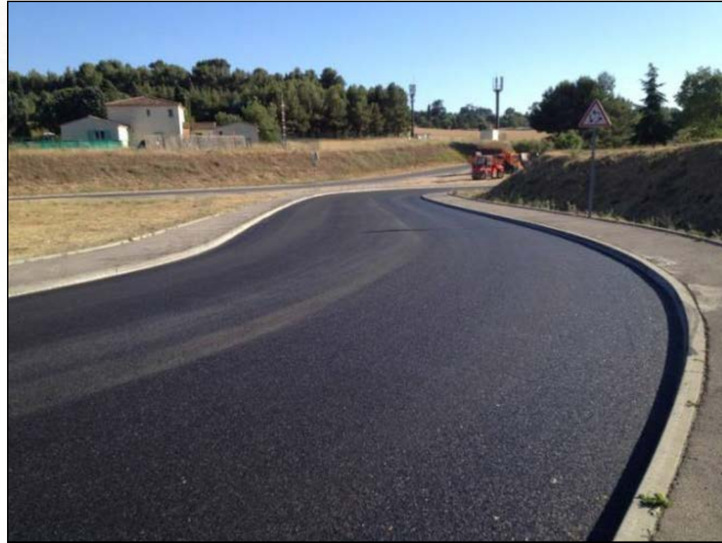
Voirie en enrobé
